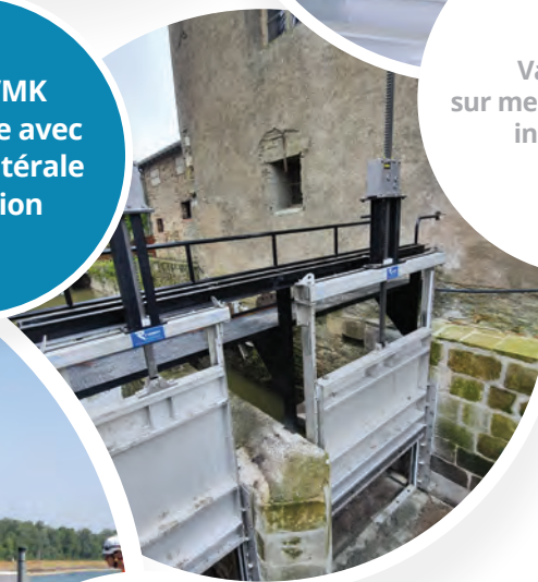
Vanne murale sur mesure à crémaillère pour une passe à poisson Dimension 2200 x 4000
