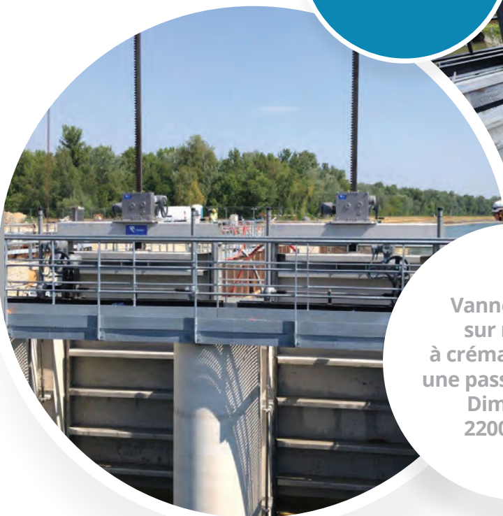
vanne VMK sur mesure avec cornière latérale de fixation
