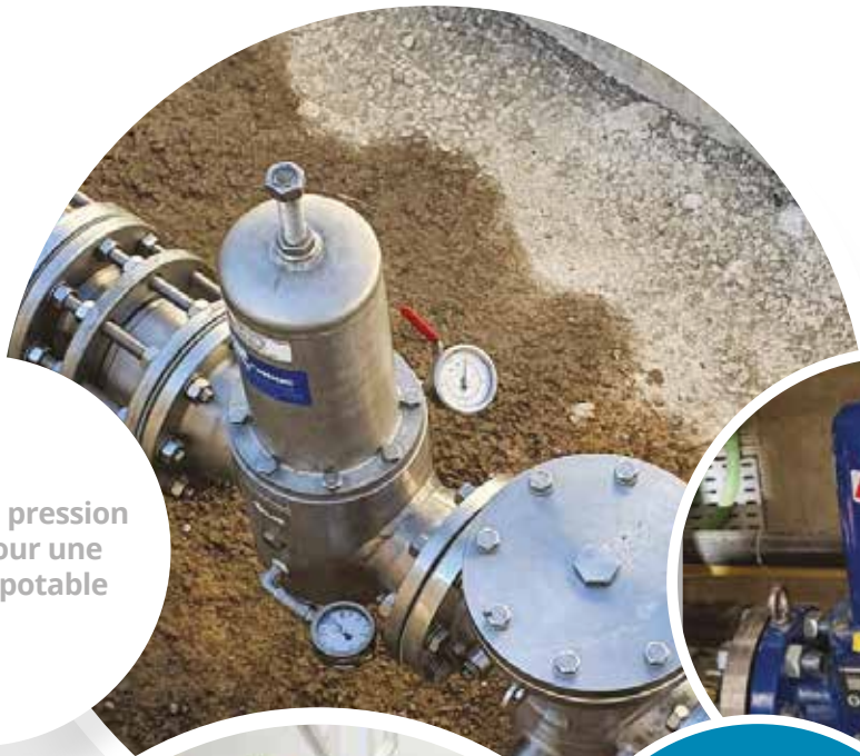
Réducteur de pression PN100 – pression de service à 60 bars pour un centre industriel des déchets
