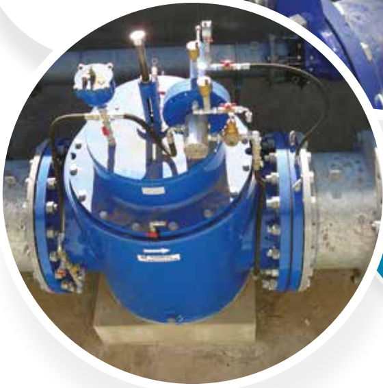
Équipement pour chambre de régulation avec EQUILAURO + vanne multifonction
