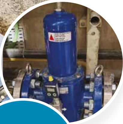
Réducteur de pression PN100 – pression de service à 60 bars pour un centre industriel des déchets
