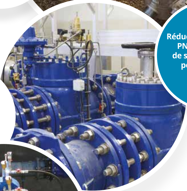
Équipement pour chambre de régulation avec EQUILAURO + vanne multifonction
