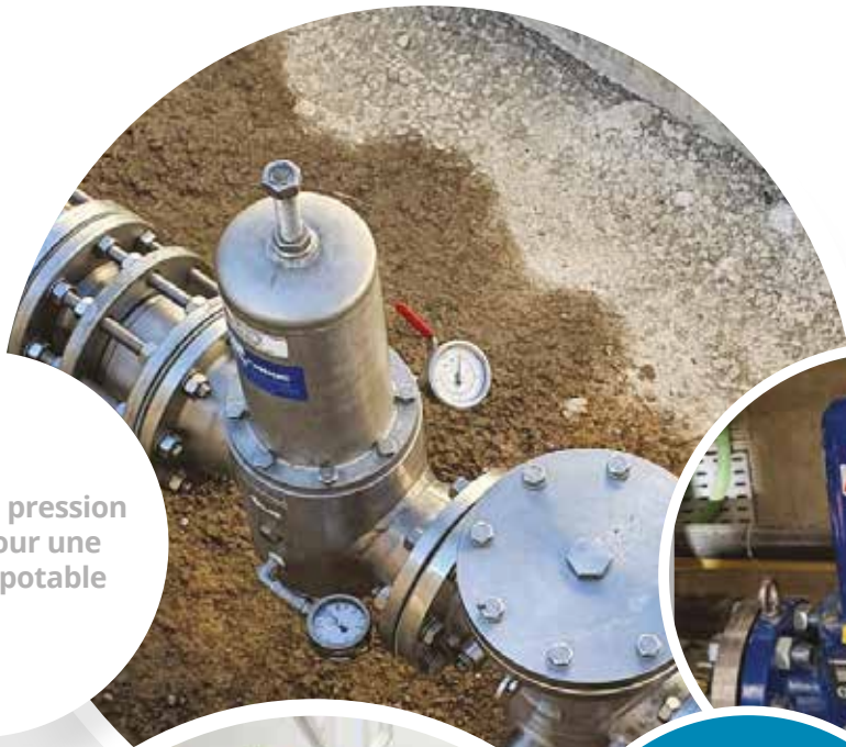
Réducteur de pression PN100 – pression de service à 60 bars pour un centre industriel des déchets
