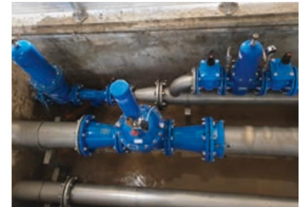
Lors d'un accès non autorisé à votre réservoir, le multi anti-intrusion (appareil de sécurité) permet le confinement de l'eau distribuée par celui-ci.
