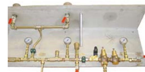
Les pilotes désolidarisés de la vanne de base
